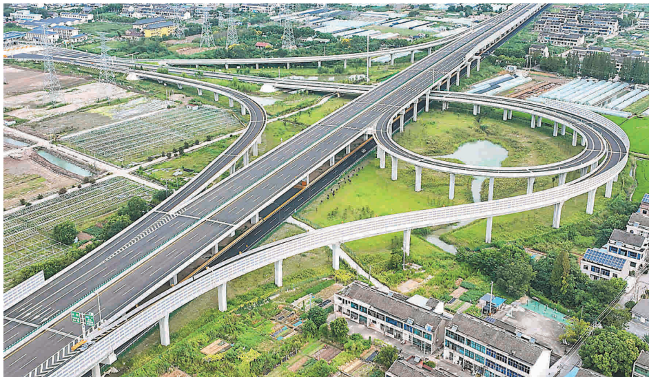
江阴靖江长江隧道是江苏省重点交通工程，目前已进入收尾阶段，交通标线设置、标识标牌安装基本到位，亮化测试同步开展，项目计划年内建成通车。图为 9 月 17 日拍摄的隧道南接线施工现场。 施柏荣 / 摄
